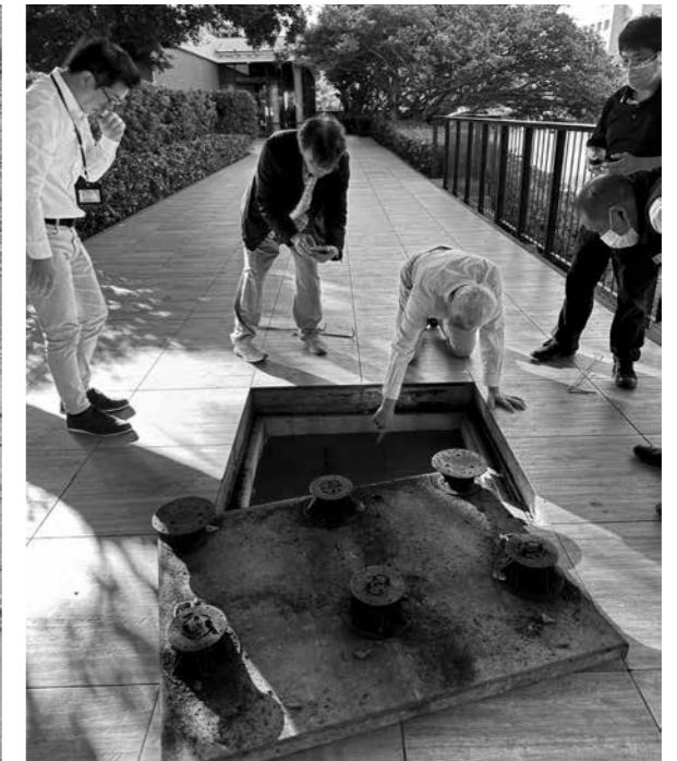
Chi-Hai Lake repairs
